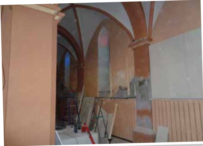
L'église en travaux.
